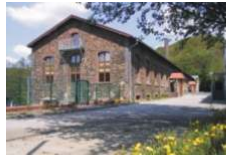
Institutsgebäude im Zschopautal (Foto: KSI Meinsberg)
