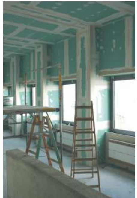
Baustelle des neuen Gläsernen Labors im Sommer 2005
